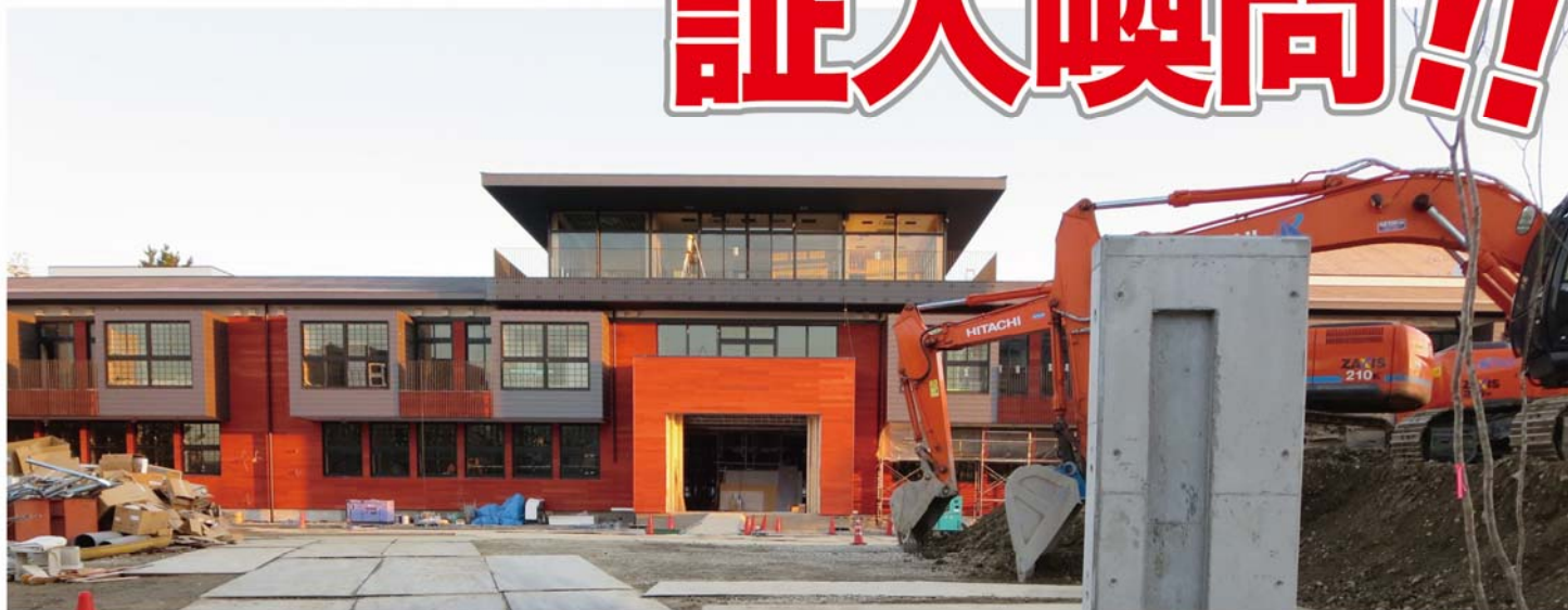
建設中の森友小学校校舎
